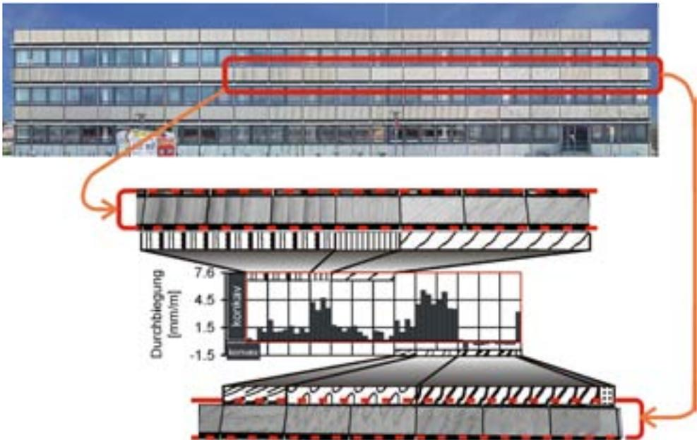
Abb. 4.11: Zusammenhang zwischen der Schnittlage der Fassadenplatten und dem Grad der Verbiegung am Beispiel der dritten Fassadenzeile der Nordfassade des Oeconomicums.
