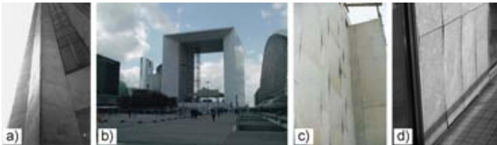
Abb. 2.8: Prominente Beispiele von Gebäuden mit verbogenen Fassadenplatten: a) Das Amoco Building in Chicago (aus Logan 2004), b) der Grande Arche de la Défense in Paris, c) die Finlandia Hall in Helsinki (um 1999) und d) das St. Marien-Hospital in Lünen (Balkon).
