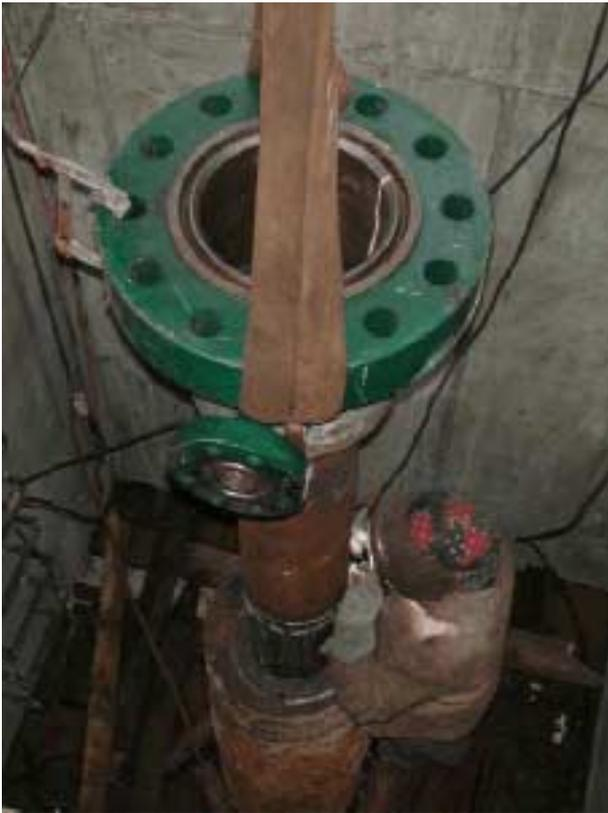
**Abbildung 3:** Aufsetzen des neuen Bodenflansches 9 5/8“ API-5000 PS / Installation of a new casinghead housing on top of the 10 year old casing
