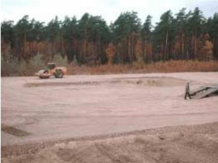
**Abbildung 2:** Errichtung des Bohrplatzes am Standort Groß Schönebeck / Preparation of the drilling site
