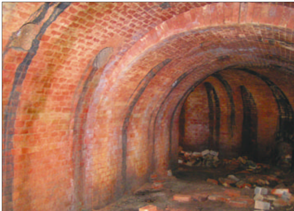
53. Wnętrze pieca do wypалу cegieł dawnej cegielni w Tuplicach 53. Innere des Ziegelbrennofens in der alten Ziegelei in Tuplices
