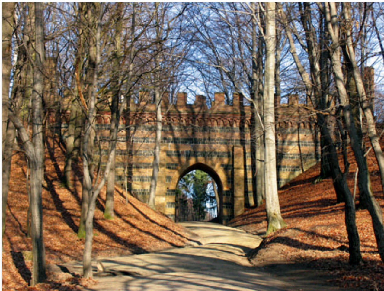
5. Widok na Wiadukt
