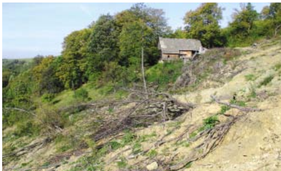
Osuwisko w rejonie Chluboce (Czechy)
