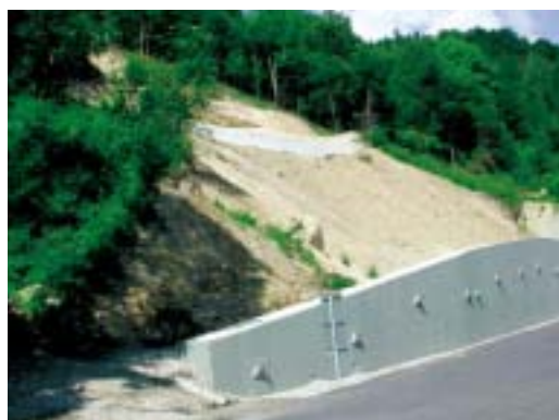
Osuwisko w Wierchomli (powiat nowosądecki) po zabezpieczeniu; widoczny mur oporowy z kotwami oraz stabilizacja geowłókninami
