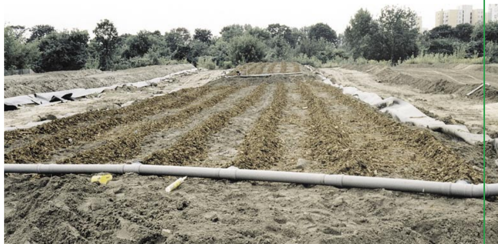
Zanieczyszczone grunty poddano rekultywacji biologicznej na specjalnie przygotowanych przyzmacach
