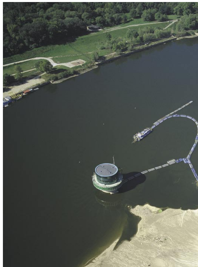
Gruba Kaśka – ujęcie wody dla prawobrzeżnej Warszawy
