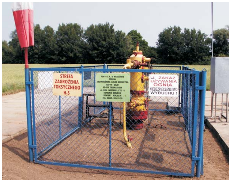
Ryc. 4. Głowica odwiertu B-28, do którego są zatłaczane kwaśne gazy zawierające \text{CO}_2 . Fot. M. Walczak
