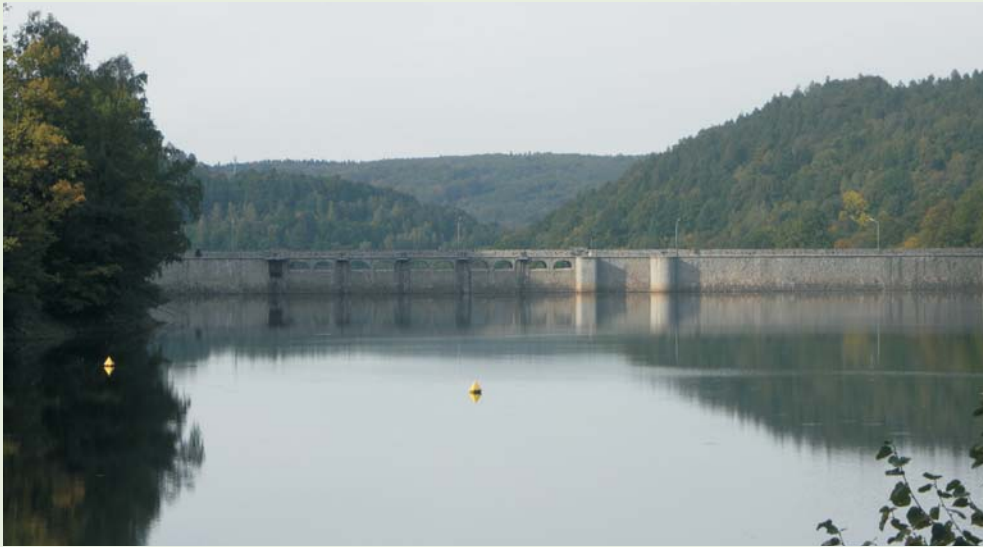
Fot. 17. Widok na zaporę Jeziora Bystrzyckiego w Zagórz Śląskim. Fot. S. Cwojdziański
