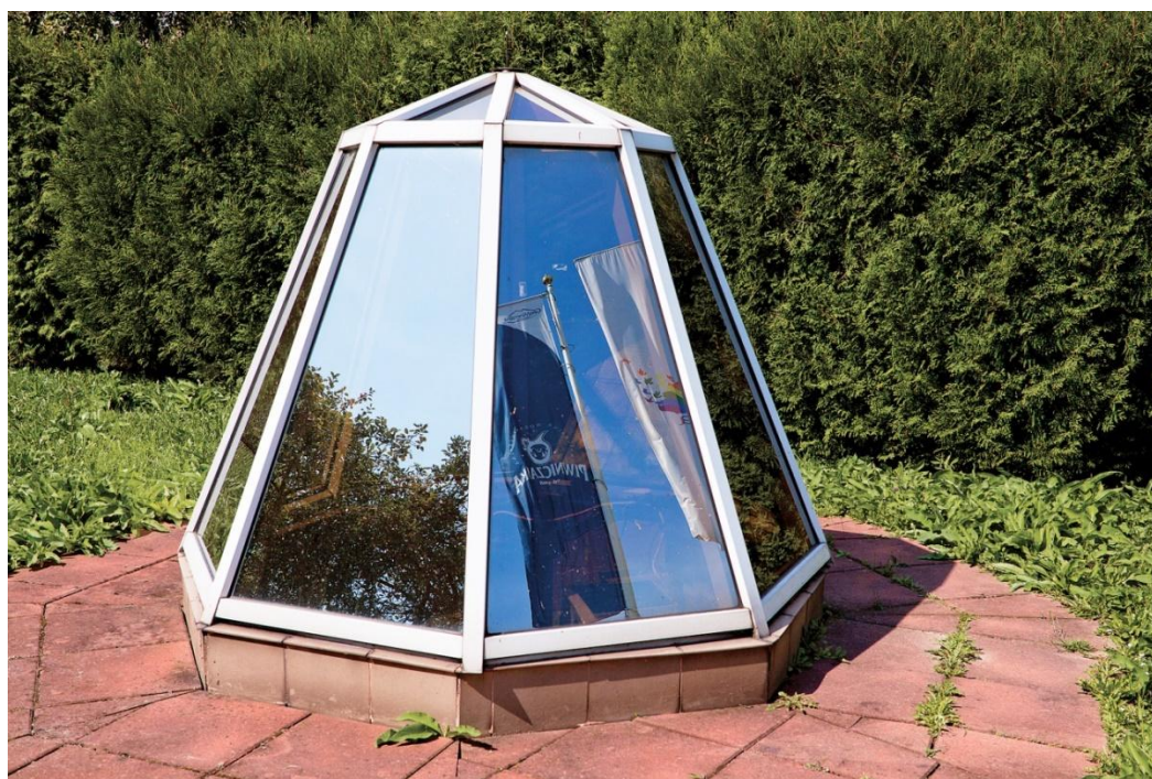
Fig. 4.2. Obudowa studziennego otworu wiertniczego ujmującego wody lecznicze w Piwnicznej-Zdroju (fot. Piwniczanka Spółdzielnia Pracy)
