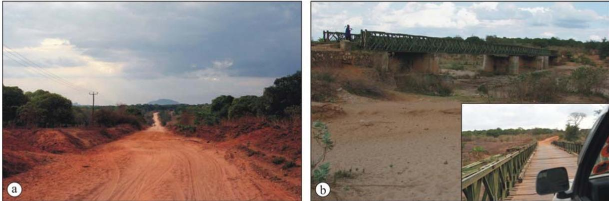
Abb. 5.3: a) Typische Wegeverhältnisse im Bereich des Vorkommens, hier W' Mtesa; b) Metallbrückenkonstruktion mit losen Holzbohlenbelag auf der Strecke Mtesa - Masasi.
