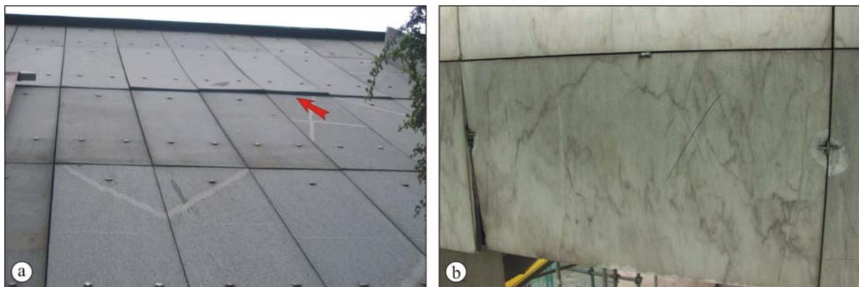
Abb. 3.80: Mangelnde Formbeständigkeit von Fassadenplatten: a) CEZLAK GRANODIORIT (Slowenien, Maxi-Market Ljubljana); b) Abplatzungen im Bereich der Ankerdorne infolge der Plattenverbiegung (Calcitmarmor ROSA ESTREMOZ, Portugal, Staatstheater Darmstadt).
