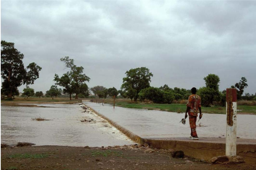
Foto 21 Betonierte Straßenfurt (*Radier*) durch den Gorouol bei Saouga mit regenzeitlichem Trockenwetterabfluss (Juli 1998).
