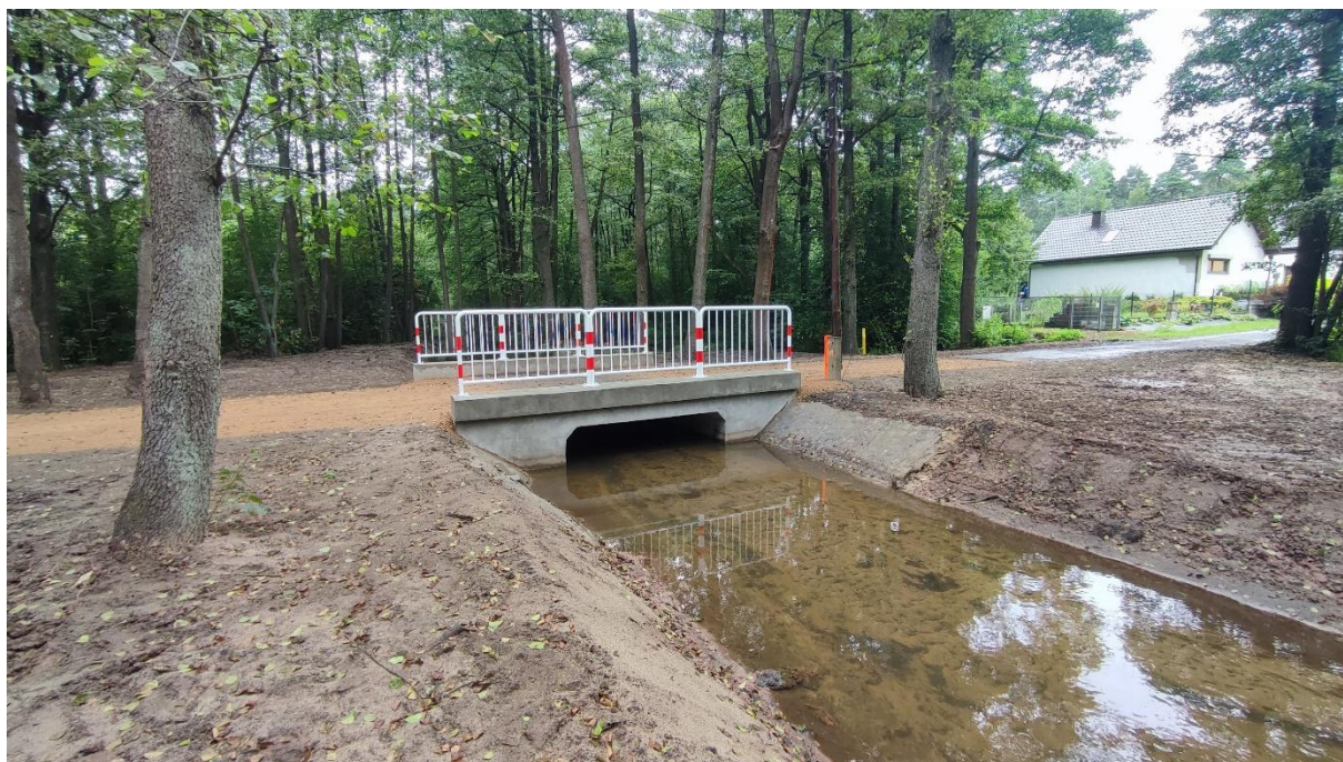
Fot. 6. Nowy przepust pod gminną drogą, ul. Ponikowska w Hutkach (fot. PIG-PIB, 24.07.2026 r.)
