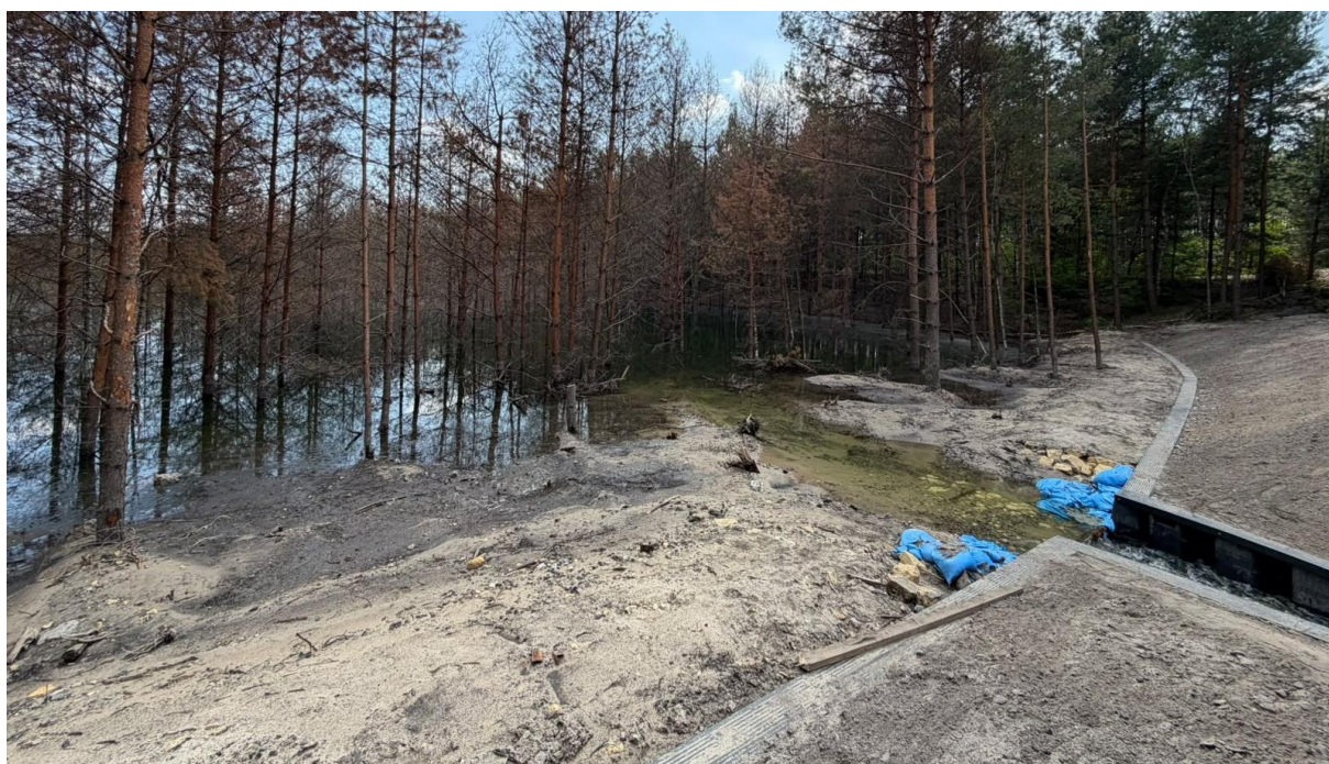
Fot. 3. Przekop oraz kanał odprowadzający wodę z zalewiska Dąbrówka (fot. PIG-PIB, 17.07.2026 r.)
