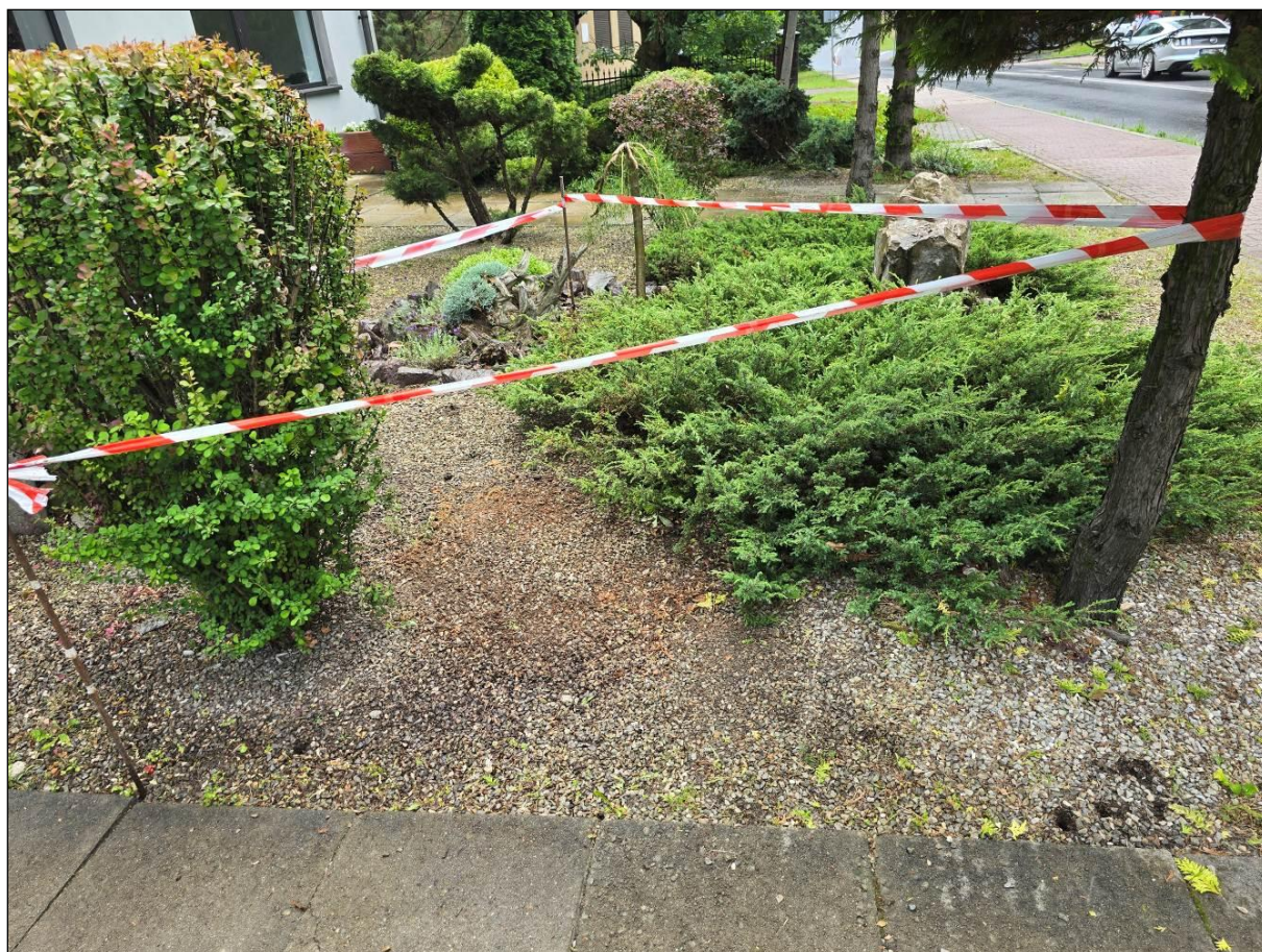
Fot. 8. Widok na obniżenie terenu przy ulicy Kolejowej w Bukownie (fot. J. Kos)
