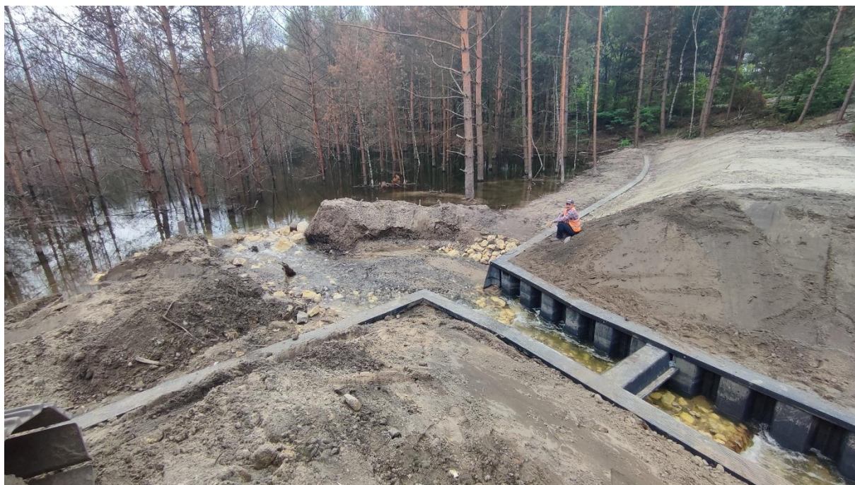
Fot. 2. Przekop oraz kanał odprowadzający wodę z zalewiska Dąbrówka (fot. PIG-PIB, 13.07.2026 r.)
