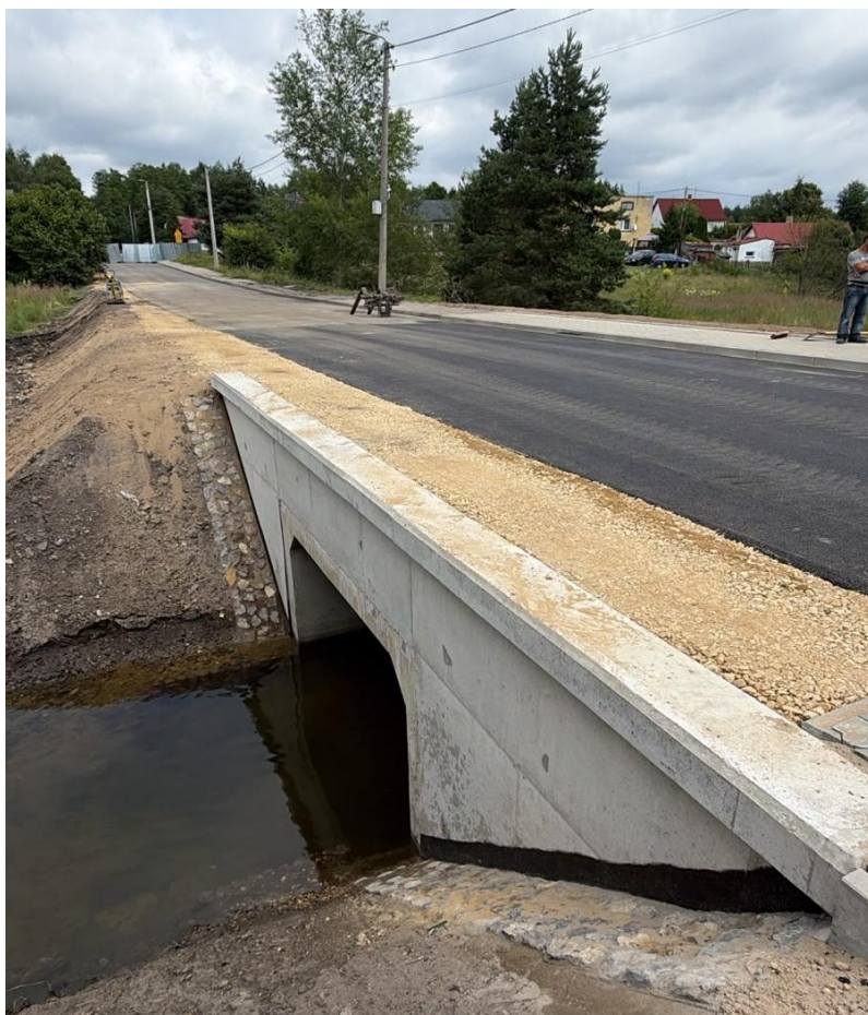
Fot. 5. Nowy przepust pod drogą powiatową, ul. Jurańska w Hutkach (fot. PIG-PIB, 13.07.2026 r.)
