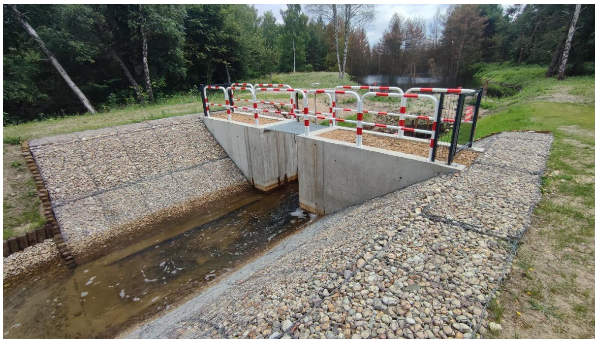
Fot. 4. Przepust i kanał odprowadzający wodę z zalewiska Hutki (fot. PIG-PIB, 13.07.2026 r.)
