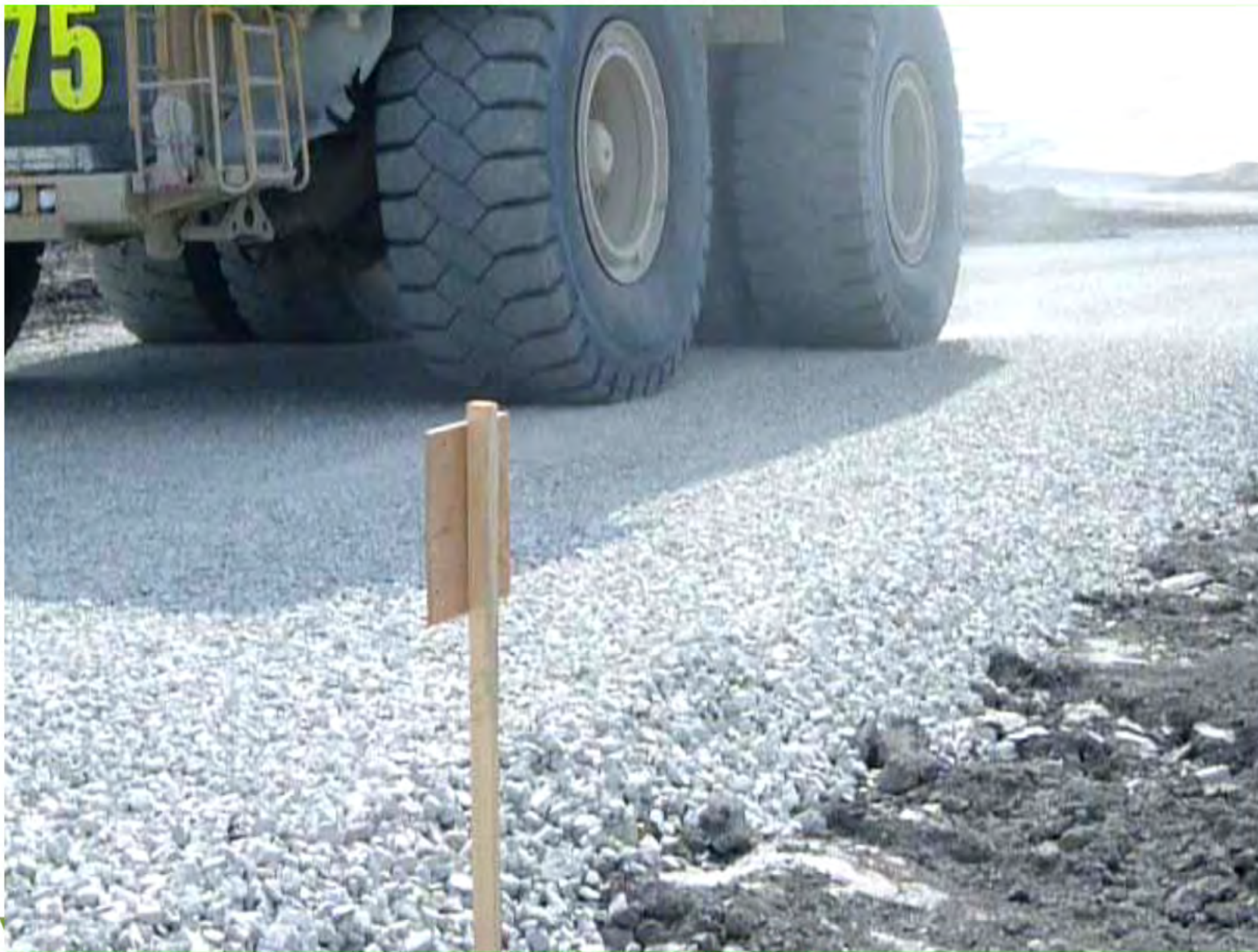
MSL z georusztem Tensar
