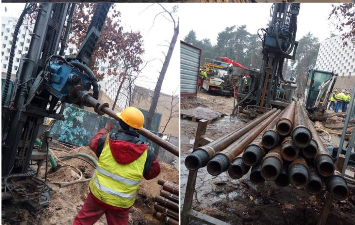
Rysunek 43 Zdjęcia z budowy magazynu BTES w Sulejówku (Euros Energy)
