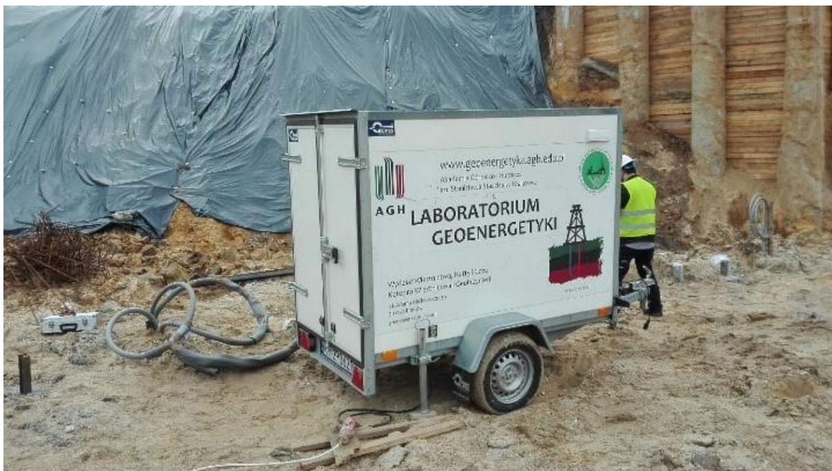
Rysunek 86 Zestaw pomiarowy Laboratorium Geoenergetyki dostarczony na dno terenu fundamentowania z wykorzystaniem dźwigu, celem wykonania testu reakcji termicznej termopala (Laboratorium Energetyki, AGH)
