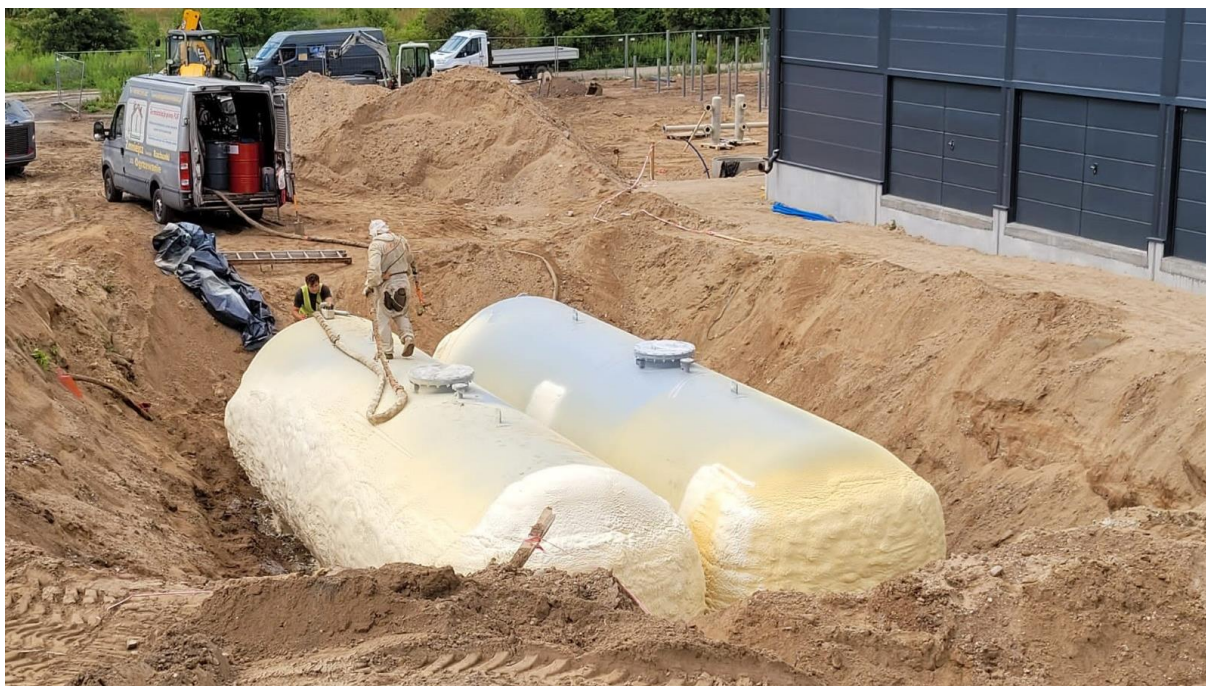
Rysunek 40 Bufor sieci ciepłowniczej - magazyn krótkoterminowy – przed zasypaniem (Euros Energy)
