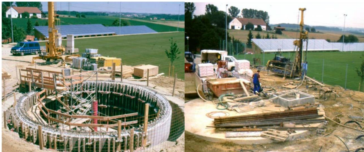
Rysunek 15 Podziemny magazyn ciepła TTES w trakcie budowy (Benner i in., 2003)
