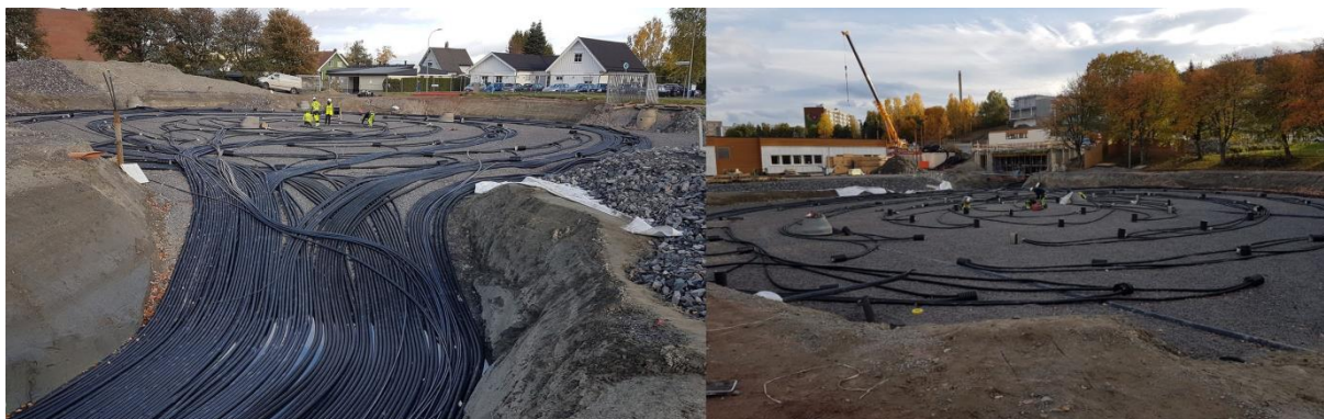
Rysunek 6 Przyłącza od pionowych wymienników ciepła w magazynie BTES podczas konstrukcji w Drammen (Norwegia) ( https://lkab.com/en/news/lkab-wassara-finalist-in-helsinki-energy-challenge/ )
