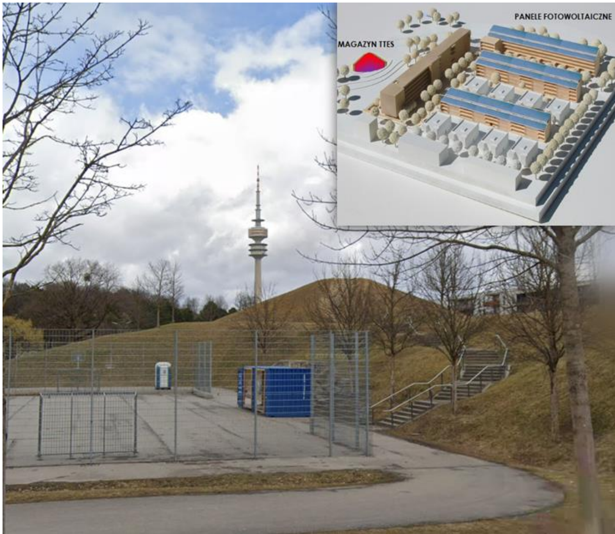
Rysunek 14 Magazyn ciepła TTES wykonany nad ziemią i obsypany (Monachium, Niemcy) (Google Map Street view, https://sdg21.eu/en/db/solare-nahwaerme-ackermannbogen )
