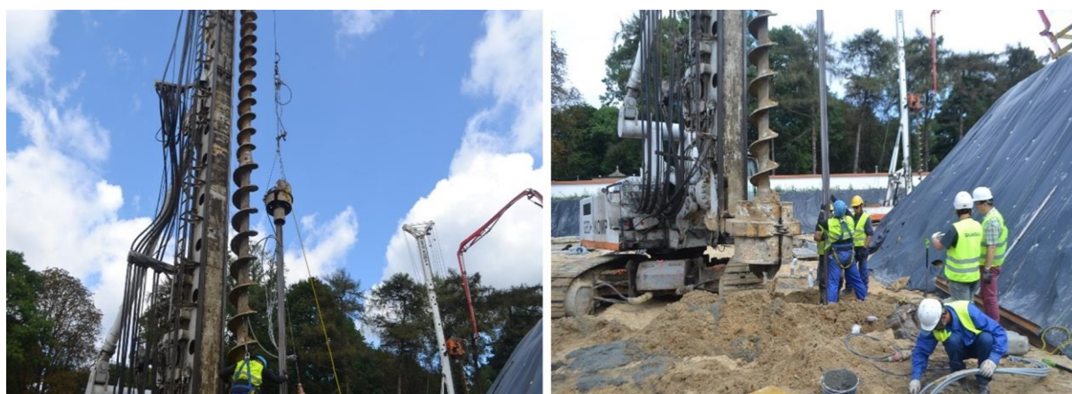
Rysunek 85 Wiertnica ślimakowa do wykonywania otworów dla pali nośnych podczas prac na ul. Rakowickiej 22E dnia 10 października 2017 r (Laboratorium Energetyki, AGH)
