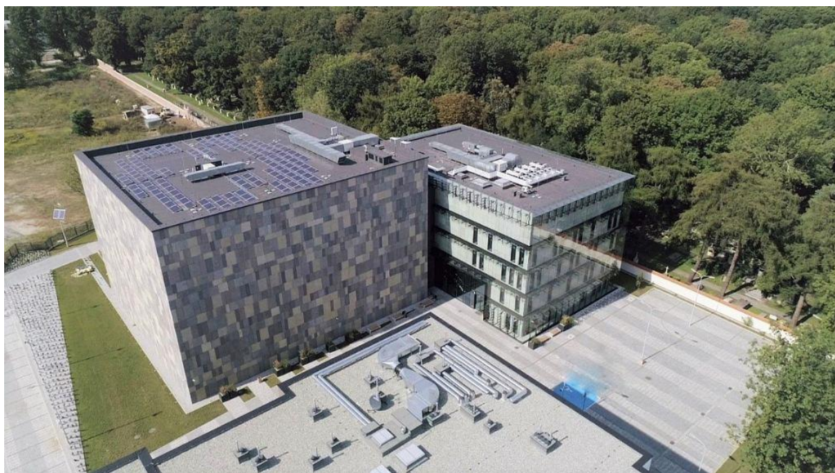
Rysunek 21 Archiwum Narodowe w Krakowie – budynek wykorzystujący technologię pali energetycznych. ( https://krakow.wyborcza.pl/krakow/7,44425,26355647,najwieksza-przeprowadzka-w-historii-archiwow-panstwowych.html )
