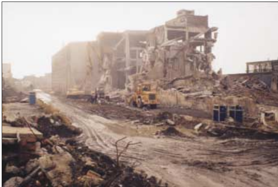
Wyburzanie zakładów chemicznych w Tarnowskich Górach w 2000 r.
