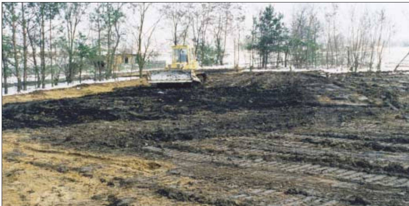
Rekultywacja obszaru mogilnika Korolówka (gmina Włodawa, woj. lubelskie); po oczyszczeniu pokrywanie terenu mieszanką glebową
