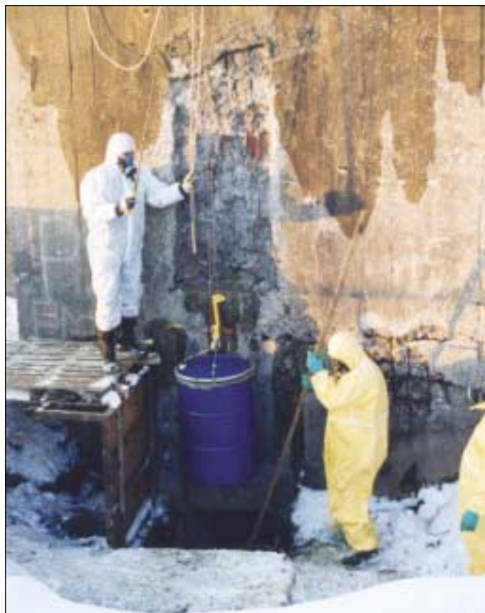
Mogilnik Wąsosz, gmina i powiat Grajewo, woj. podlaskie; wydobywanie beczek z odpadami
