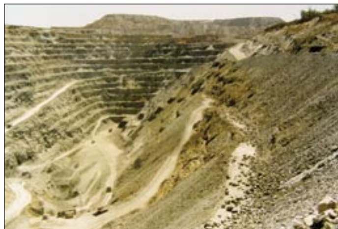
Miejsce katastrofy w kopalni rud metali w Aznalcóllar, w Hiszpanii
