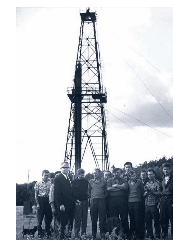
Doc. Jan Wyżykowski (czwarty z lewej) z grupą wiertaczy, z którymi wykonał historyczny odwiert, fot. zbiory PIG-PIB
