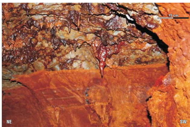
Ryc. 3. Nacieki żelaziste na stropie i ociosach sztolni Leopolda (podziemna trasa turystyczna „Kopalnia Św. Jana” w Krobicy). Fot. P.P. Zagożdżon
