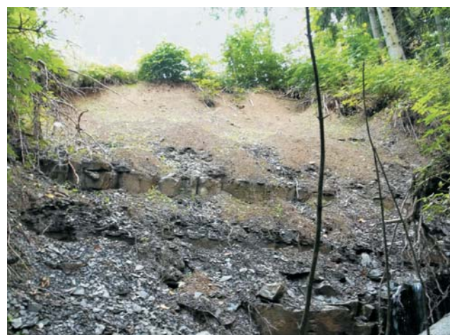
Ryc. 6. Jedno z wielu płytkich podcięć stoków przez potok, które powstały w wyniku ulew z 31 lipca 2010 r. Fig. 6. One of numerous shallow slope undercuts that developed as a results of downpour of July 31, 2010
