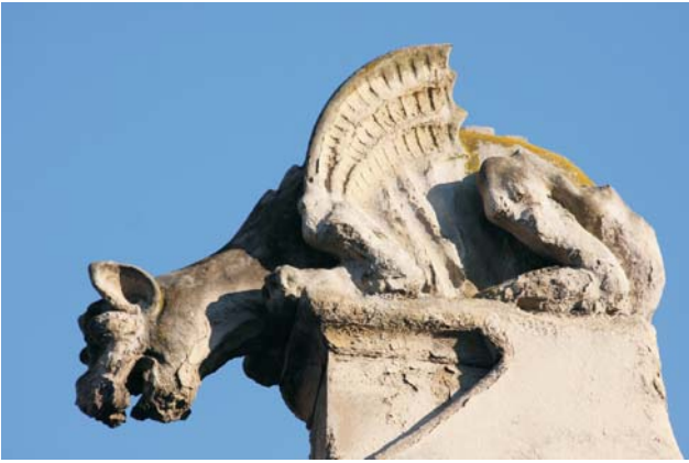
Ryc. 13. Chimera na narożu dachu dawnej podstacji elektrowni miejskiej na rogu ulicy Łobzowskiej 9–11 i Biskupiej 1; wapień pińczowski
