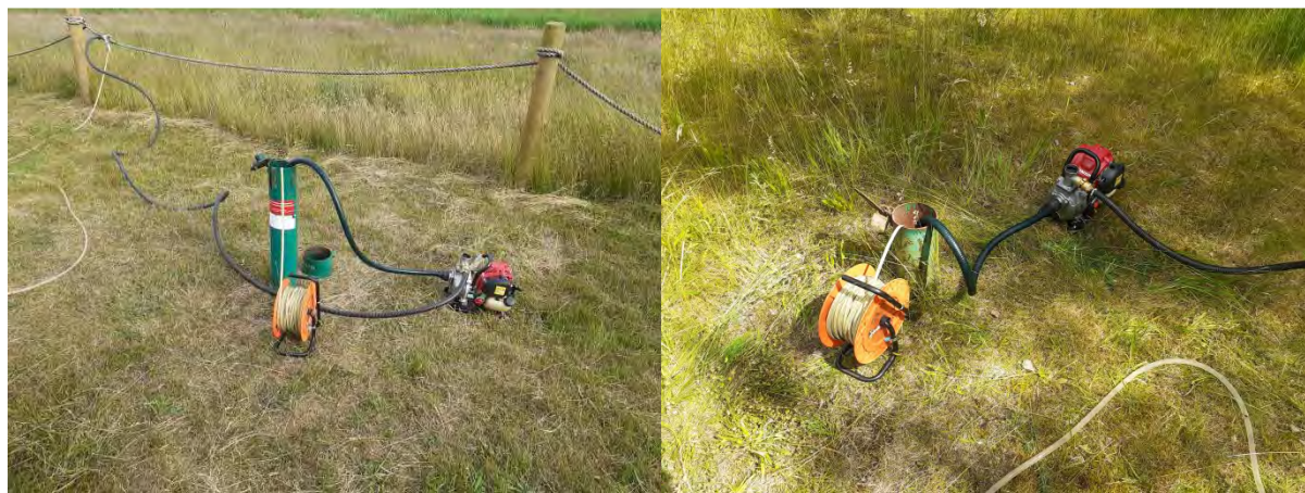
Fot. 7.4.1. Pobór próbek wód podziemnych metodą konwencjonalną (pompowania oczyszczające – wolumetryczne) z wykorzystaniem pompy ssącej (S) (punkt monitoringowy SOBWP II/1751/1 Kluki oraz SOBWP II/707/1 Hel)
