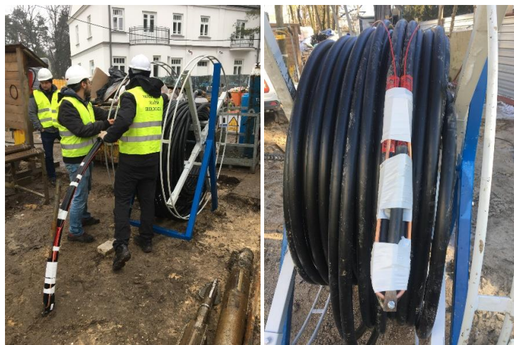
Rysunek 1. Montaż instalacji DTS w Sulejówku.
