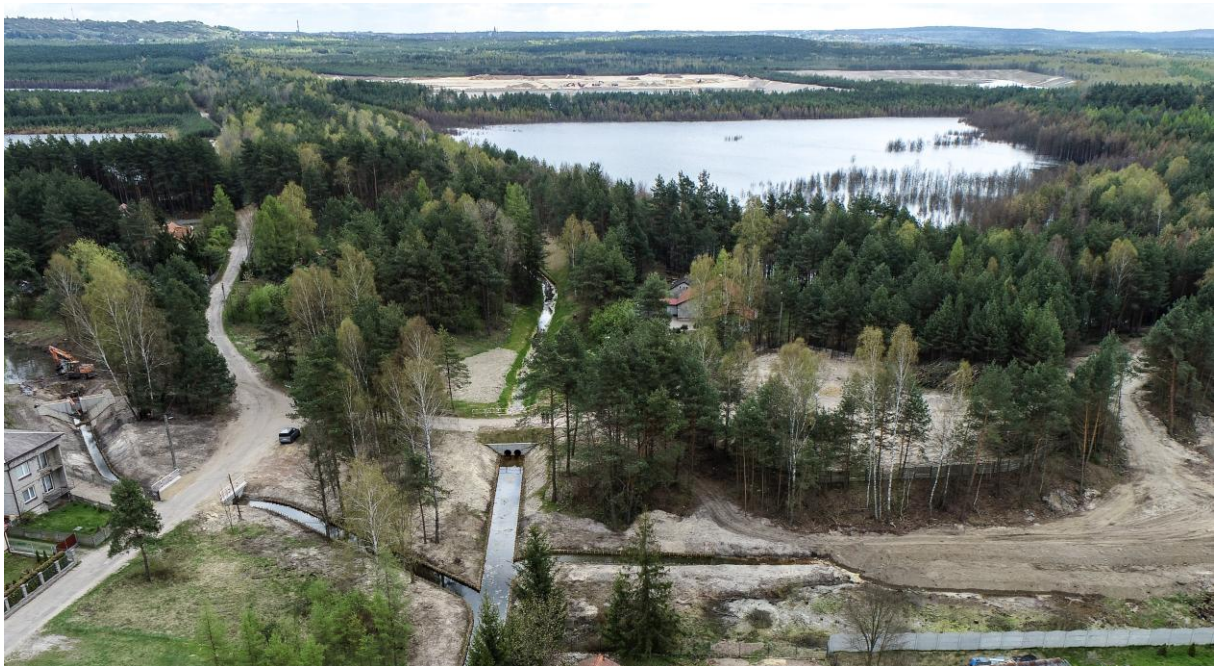
Ryc. 5. Widok z lotu ptaka na zalewisko Dąbrówka, roznos Sztolni Ponikowskiej oraz sieć kanałów i jazów spustowych do zrzutu wód z zalewisk (fot. PIG-PIB, 28.04.2026 r.)
