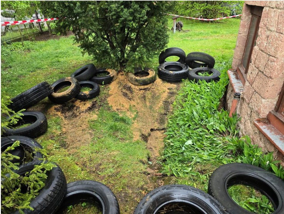
Ryc. 19. Widok na lej zapadliska (fot. J. Kos)
