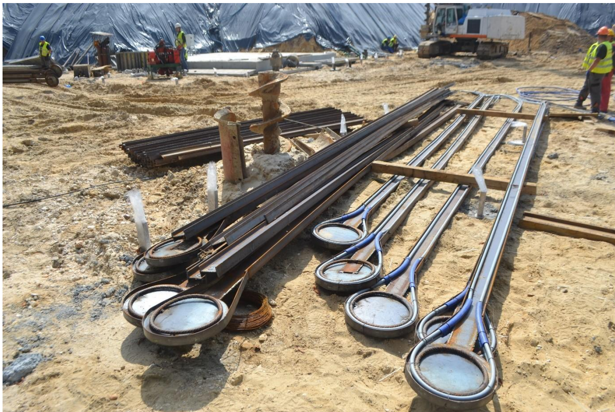
Zbrojenie pali w formie dwu-teownika wraz z umieszczoną U-rurką wymiennika ciepła z zachowaniem minimalnego promienia gięcia rur PE Xa
