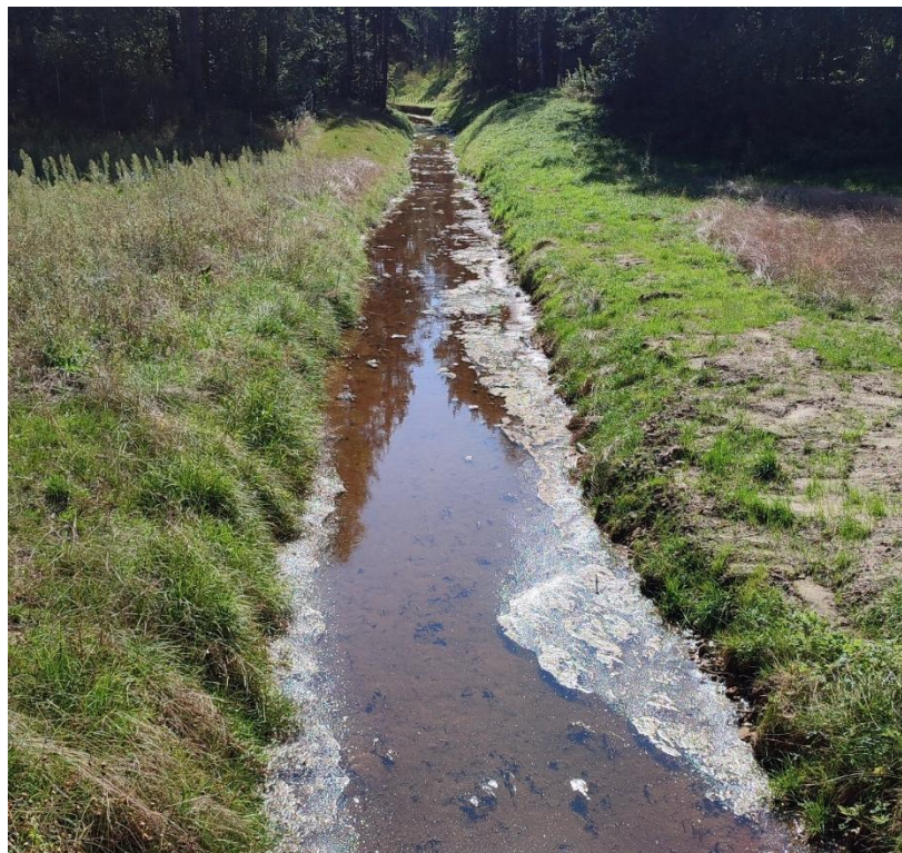
Fot. 3. Oczyszczone koryto kanału Sztolni Ponikowskiej w Hutkach (fot. PIG-PIB, 27.08.2026 r.)
