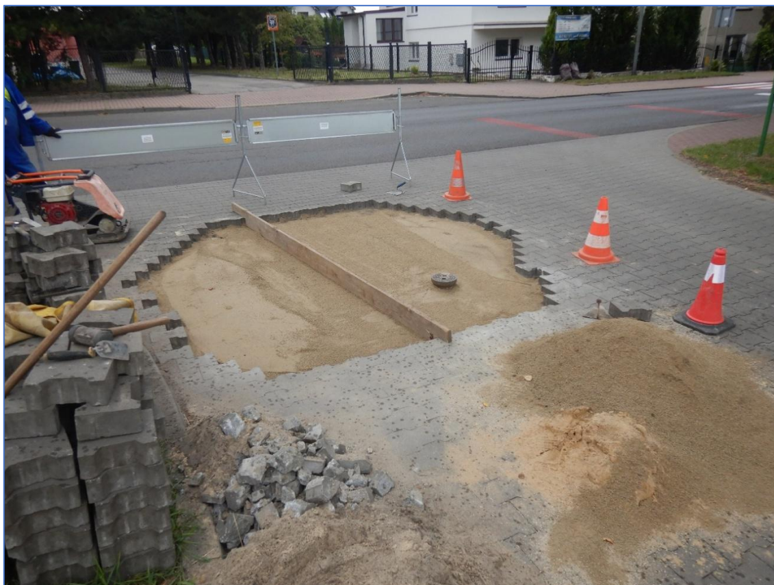
Ryc. 24. Odbudowana podbudowa kostki brukowej w miejscu powstałej deformacji (fot. M. Zajęc).
