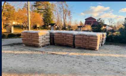
18t cementu pod budowę Dziennego Dому Pomocy HARCDOM w Smerzynie
