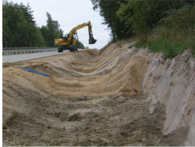
Autostrada A-4 Wądroże W
