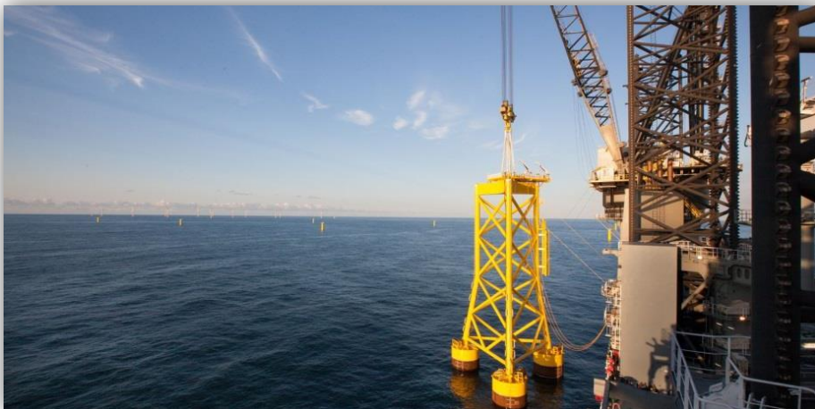
Przykładowa konstrukcja typu jacket
