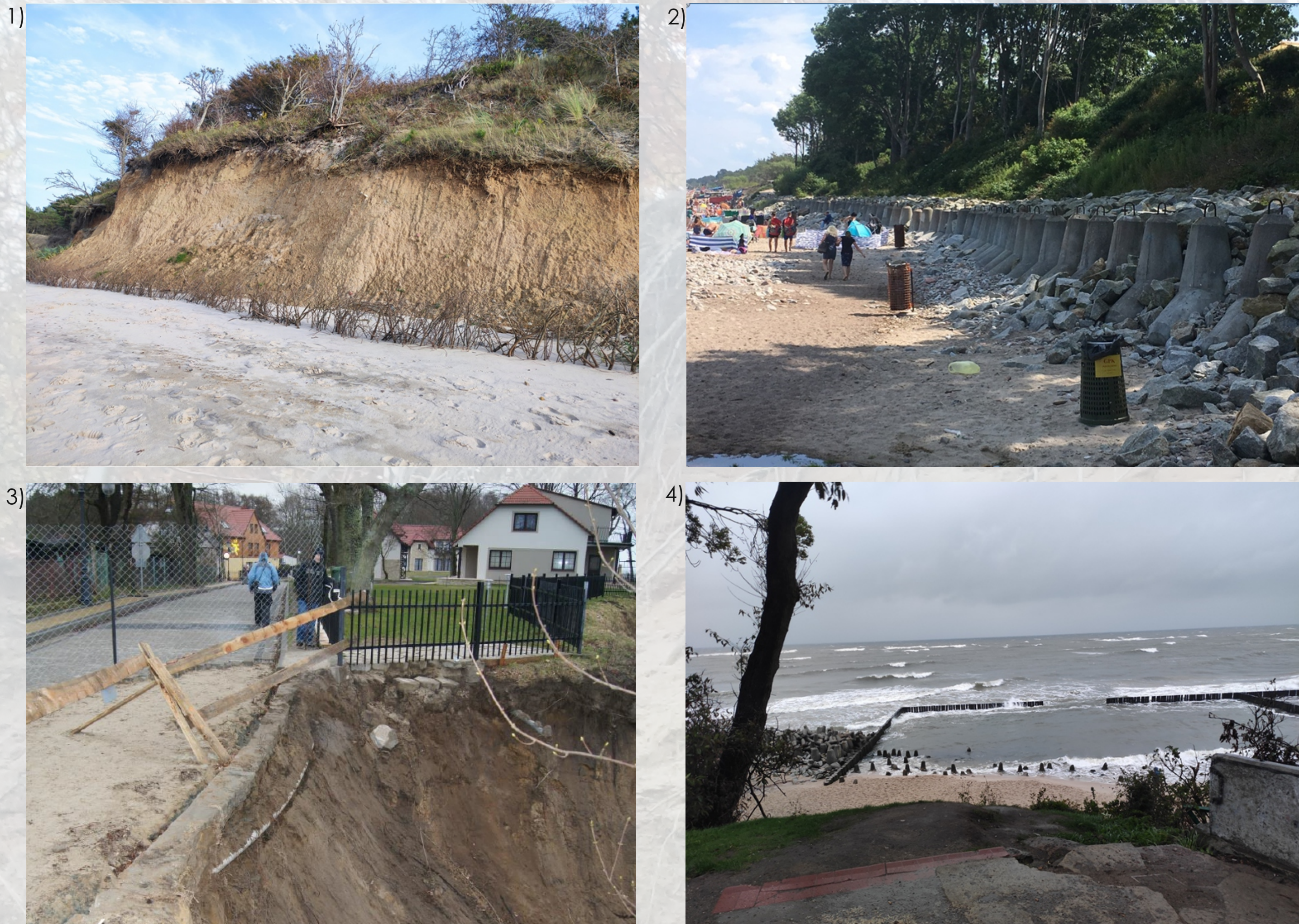
Zdjęcia w Jarosławcu: 1) klify z gliny zwałowej z domieszką głazów skał skandynawskich, 2) zabezpieczenie podstawy klifu w centrum Jarosławca, 3) uszkodzona droga przez osuwisko, 4) widok z klifu na zabezpieczenia plaży w pobliżu wejścia nr 4 (fot. J. Kobiela)
