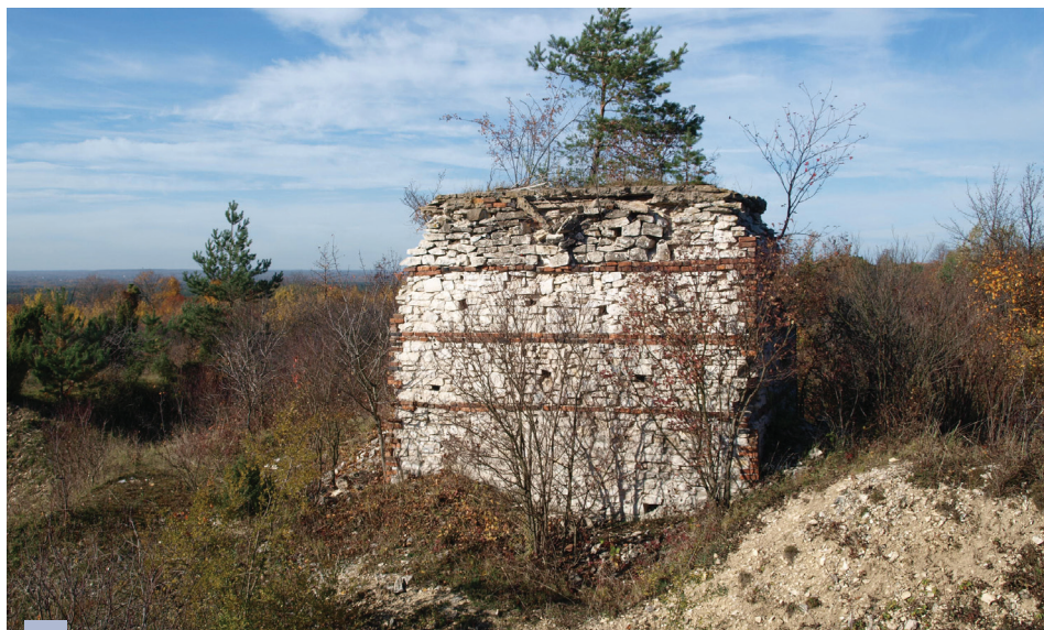
Piec wapiennicy w Kamieniołomie Koniecznego. Fot. M. Krzczyńska
