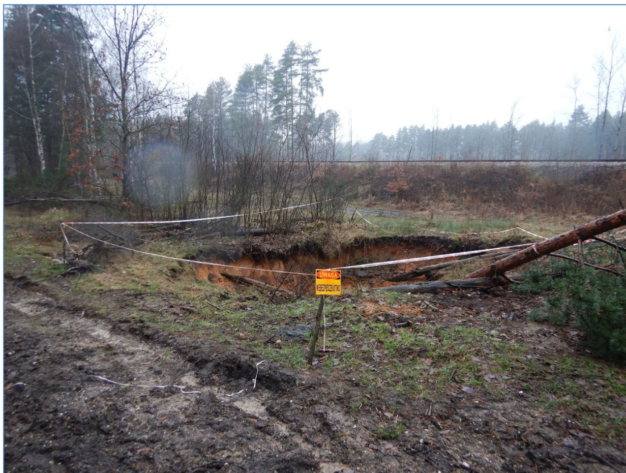
Ryc. 4. Zapadlisko z dnia 07.03.2024 r. (nr 5) w pobliżu nasypu linii kolejowej P205 (fot. S. Kamieniarz, 12.03.2024 r.)
