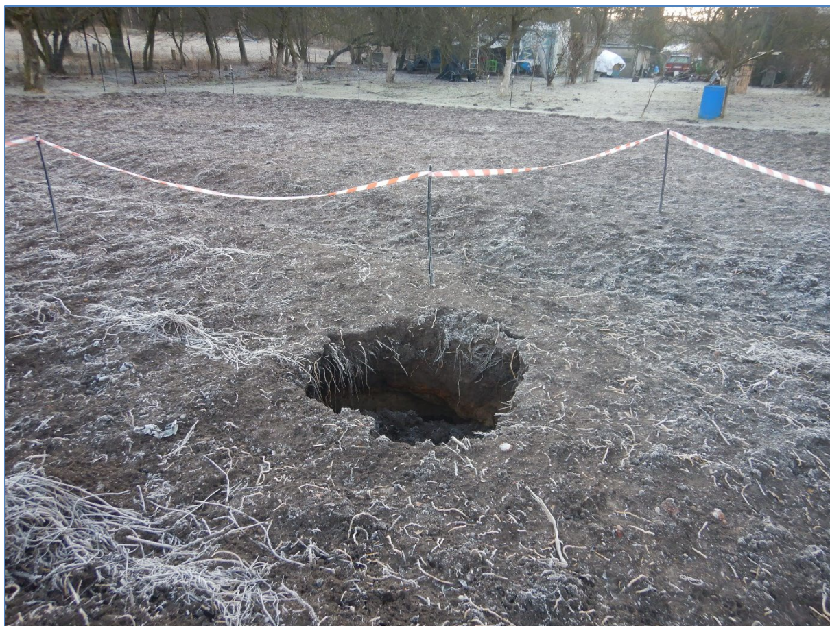
Ryc. 6. Zapadlisko z dnia 29.01.2024 r. (nr 12) przy ul. Grunwaldzkiej (fot. S. Kamieniarz, 30.01.2024 r.)
