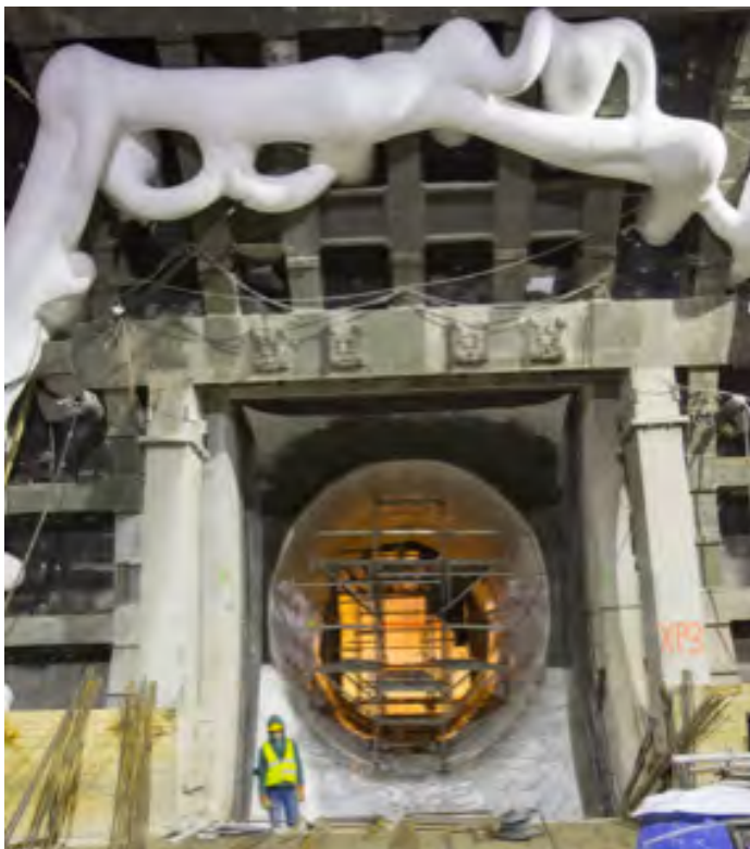
Mrożenie gruntu podczas budowy przejść poprzecznych (ewakuacyjnych). Zasolenie wód gruntowych przyczyniło się do opóźnień w procesie mrożenia
