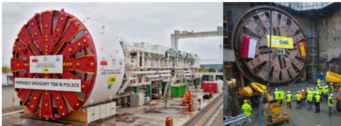
Maszyna drążąca TBM – ochrzczona słowiańskim imieniem „Damroka”
