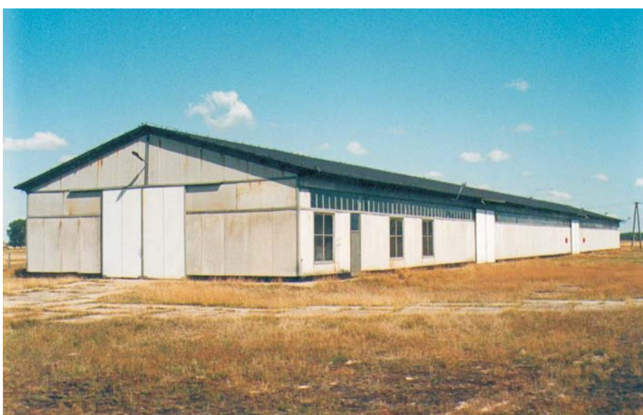
Ryc. 3. Jedna z największych hal magazynowych we wszystkich archiwach rdzeni CAG, wybudowana w 1988 roku, magazyn nr 6 w Hołownie. Fot. M. Graniczny
