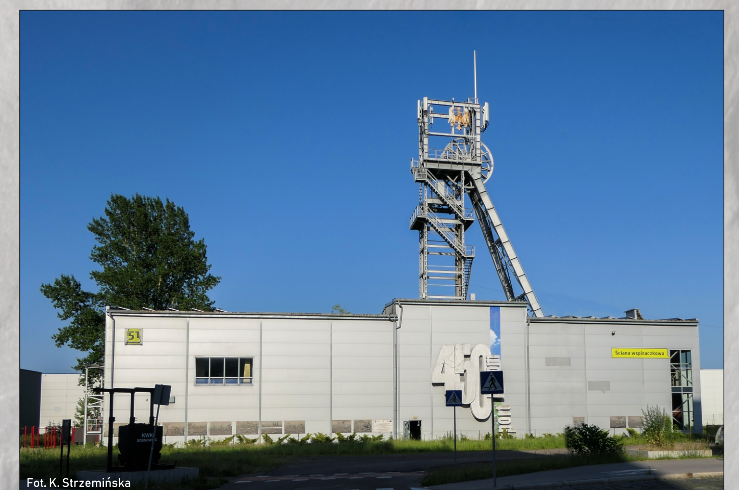
Ściana wspinaczkowa poziom 450 – teren byłej kopalni Sosnowiec.
