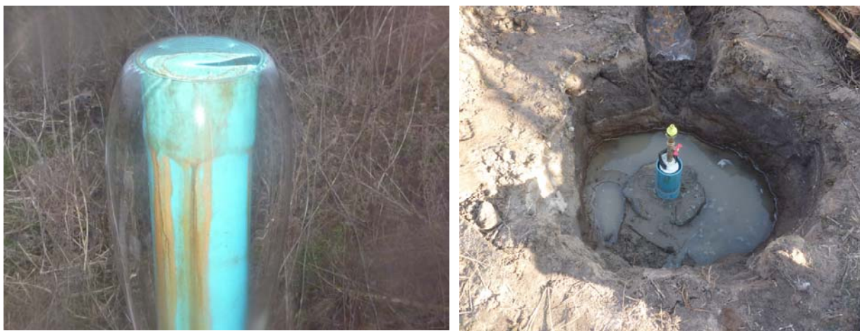
Ryc. 39.9 Otwór obserwacyjny II/1793 Koźminek w trakcie prowadzenia prac związanych z zamknięciem samowypływu i założeniem głowicy ciśnieniowej oraz obudowy termicznej
