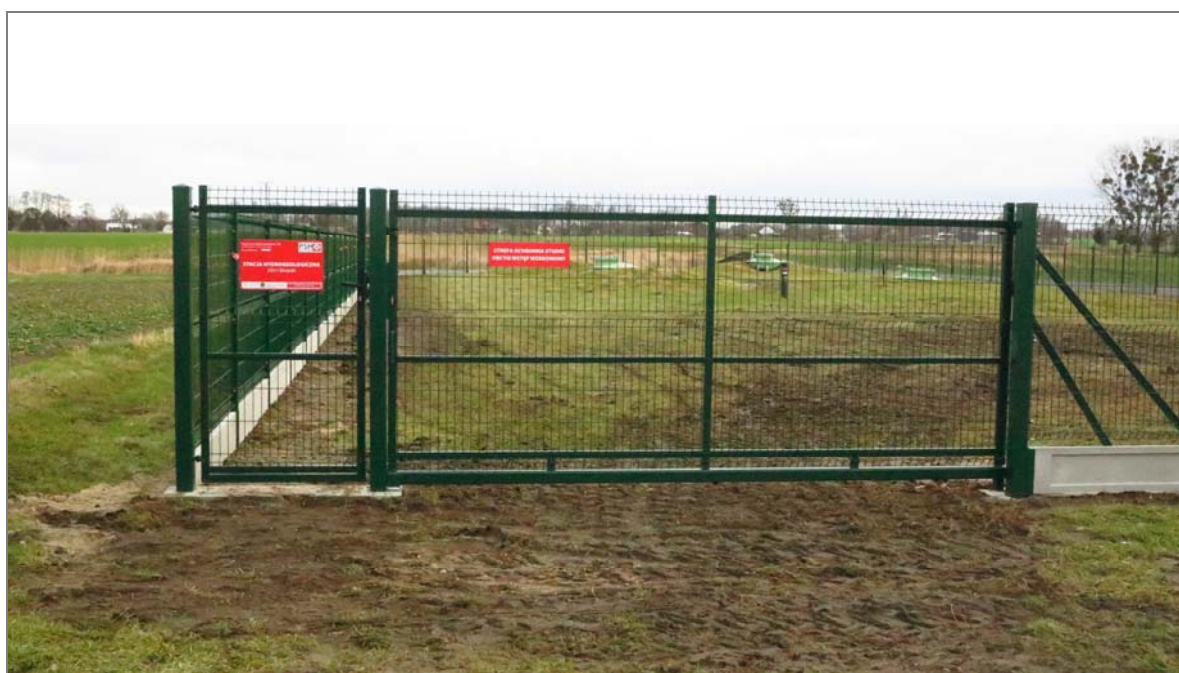
Ryc. 39.5 Stacja hydrogeologiczna I/911 Wrzoski (woj. opolskie) – brama wjazdowa i ogrodzenie terenu stacji hydrogeologicznej
