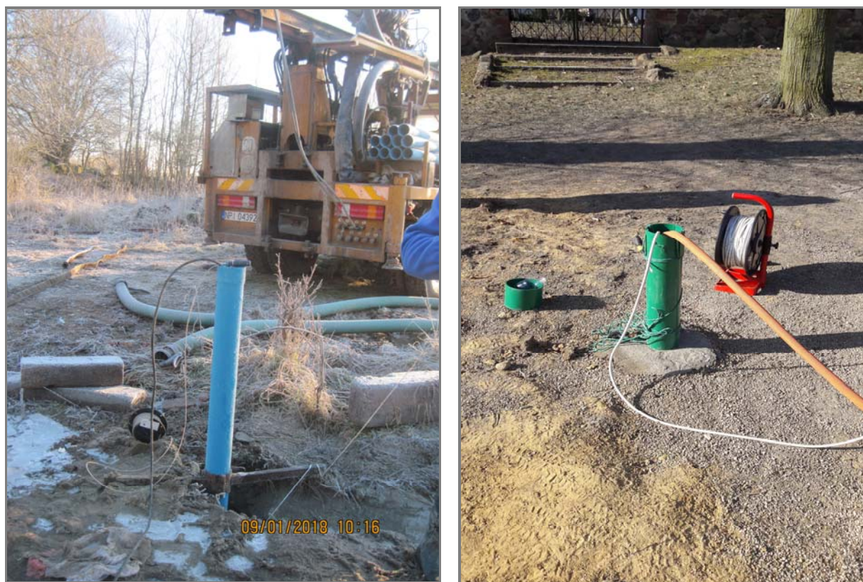
Ryc. 39.3 Piezometry monitoringu granicznego Kierno (woj. warmińsko-mazurskie) i Barnisław (woj. zachodnio-pomorskie) w czasie prac związanych z wykonaniem otworów
