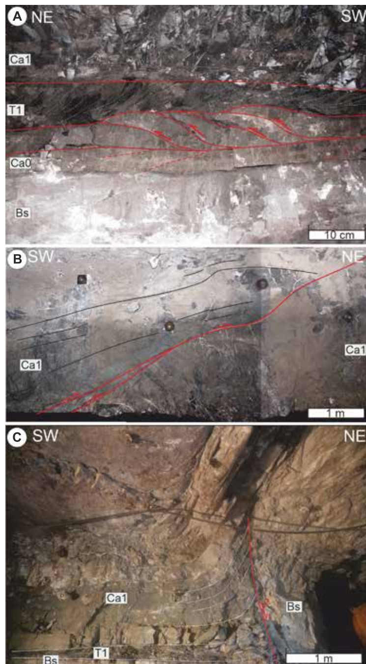
FIG. 5. Przykłady struktur kompresyjnych w spągu cechsztyń; A dupleks warstwy dolomitu granicznego; B nasunięcie w wapieniu cechsztyńskim; C uskoc normalny poddany inwersji; Bs – piaskowiec białego spągowca; Ca0 – wapień podstawowy; Ca1 – wapień cechsztyński; T1 – łupek miedzionośny. Numery przy strzałkach oznaczają kolejność przemieszczeń na uskoku
