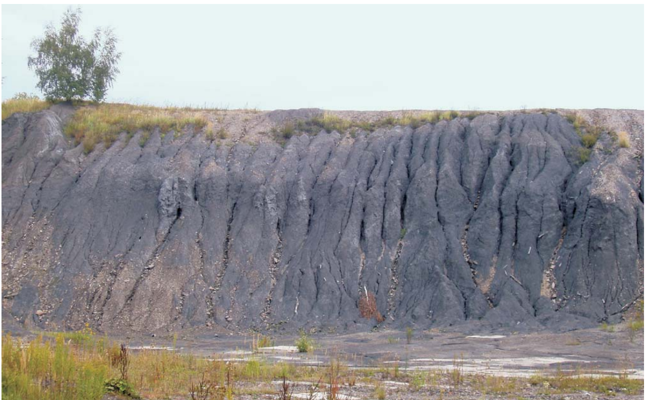
Ryc. 5. Odslonięte osady poflotacyjne w dnie nieczynnego osadnika 11-3 w Wałbrzychu Śródmieściu. Obie fot. J. Wójcik Fig. 5. The outcrop of post-flotation wastes in the bottom of inactive settling pond (11-3) in Wałbrzych Śródmieście. Both photos by J. Wójcik
