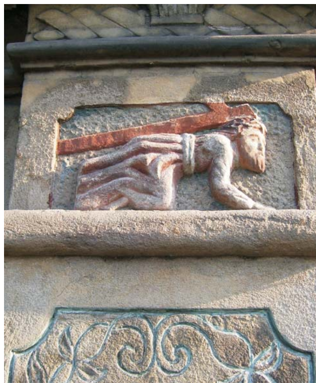
Ryc. 6. Fragment Figury św. Floriana, z 1871 r. (skrzyżowanie ulic Korepty i Ks. Popiełuszki), nieznannej fundacji. Obserwowany wzrost szorstkości powierzchni kamienia spowodowany erozyjnym oddziaływaniem opadów atmosferycznych
