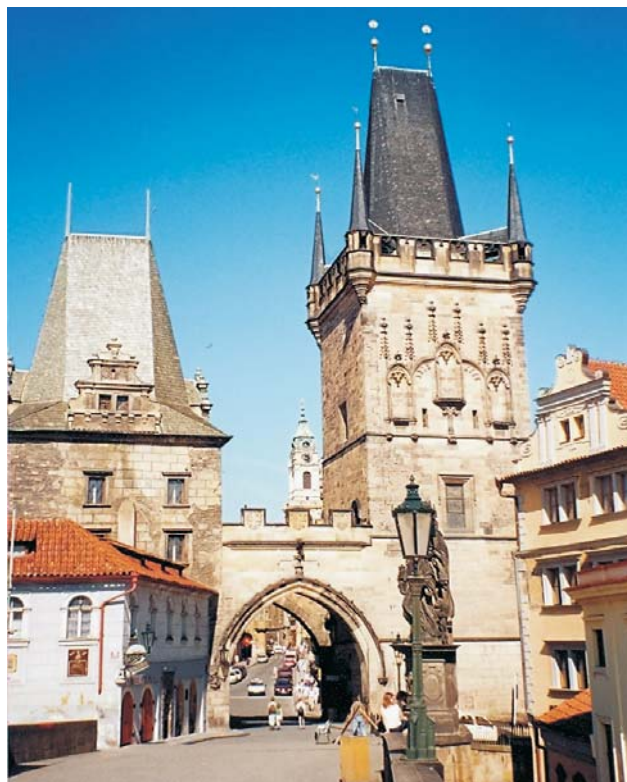
Ryc. 3. Dwie Malostranské věže na zachodnim końcu mostu. Zbudowane głównie z piaskowca arkozowego i „opuki”, dach wykonany z fyllicy. Niższa z XII w., wyższa z XV w. Fot. A. Kozłowska
