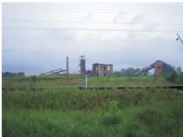
Ryc. 2. Nieczynna kopalnia soli potasowych w Stebniku (zachodnia Ukraina). Fot. K. Jarmołowicz-Szulc
