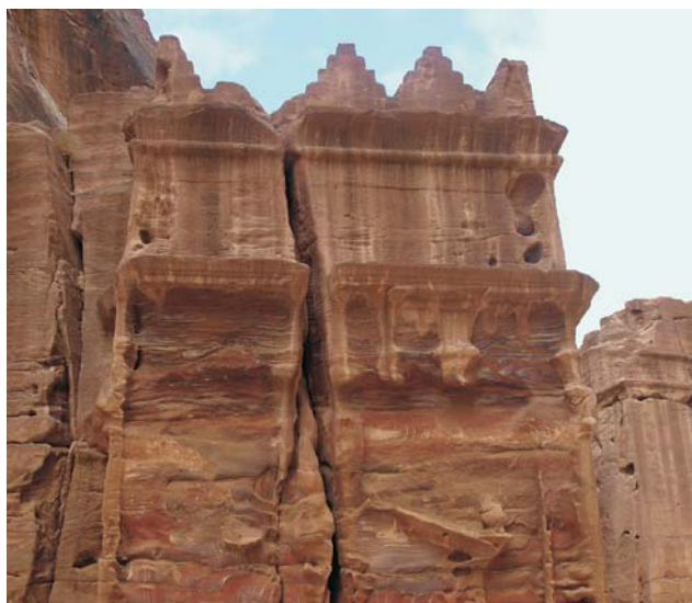
Ryc. 6. Grobowiec nr 70. Efekt zniszczeń spowodowany zmianą kierunków krążenia wód w skale, około 20 lat temu. Widoczny jest dobrze rozwinięty system szczelin
