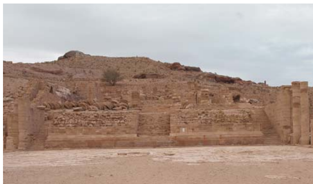
Ryc. 5. Rzymska świątynia. Po lewej stronie widoczne kolumny przewrócone podczas jednego z trzęsień ziemi
