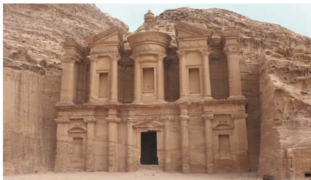
Ryc. 4. Klasztor. Intensywne działanie korazji widoczne jest do wysokości 3 metrów
