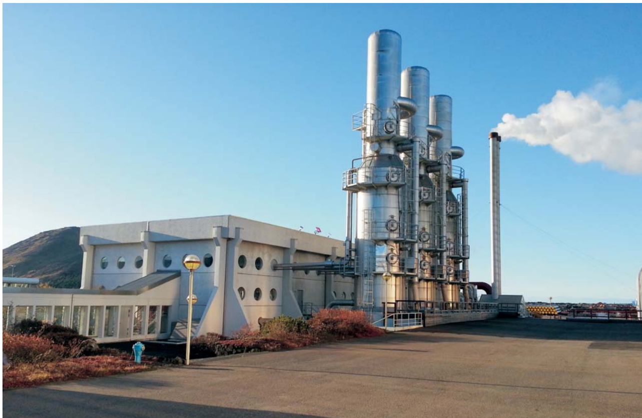
Ryc. 3. Siłownia geotermalna Svartsengi (Islandia) wykorzystująca oprócz klasycznej turbiny na parę geotermalną obieg ORC Fig. 3. Geothermal power plant Svartsengi (Iceland) utilizing ORC cycle in addition to the classical steam turbines
