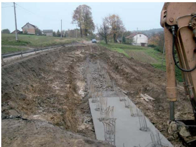
Ryc. 18. Stabilizacja osuwiska w Strzeszynie. Wszystkie fot. Z. Bednarczyk Fig. 18. Strzeszyn landslide stabilization. All photos by Z. Bednarczyk
