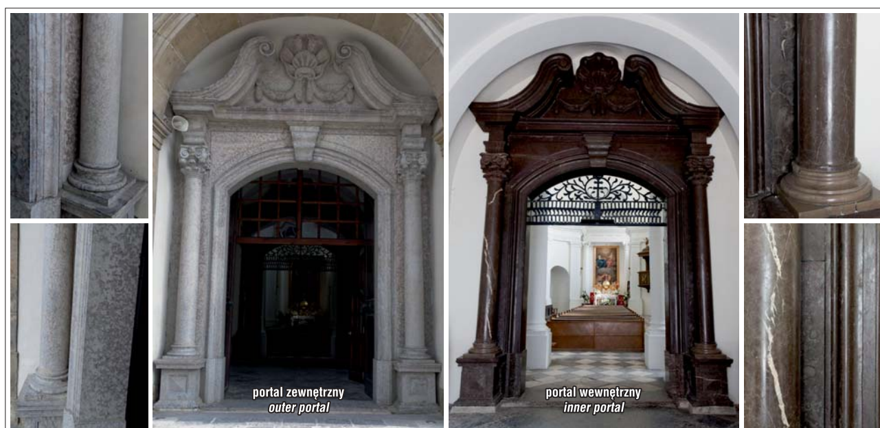
Ryc. 18. XVIII-wieczne główne portale bazyliki (zewnétrzny i wewnétrzny), widoczne rózne stopnie zwiétrzenia. Ryc. 15, 18 fot. D. Szrek Fig. 18. 18 th century main portals of the church (outer and inner), visible different states of weathering. Figs 15, 18 photo by D. Szrek
