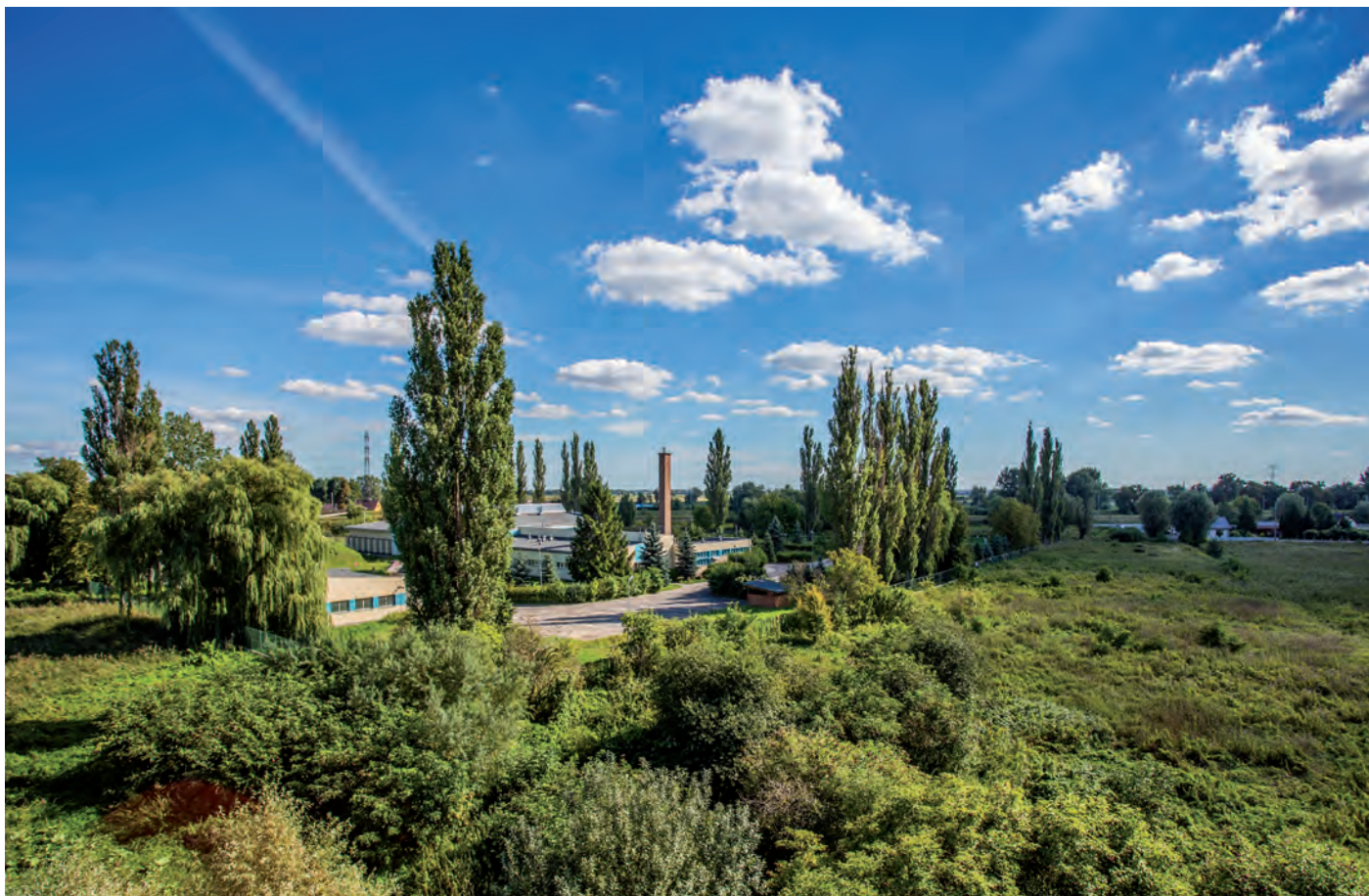
Ryc. 1. Stacja uzdatniania wody ujęcia „Lipce”
