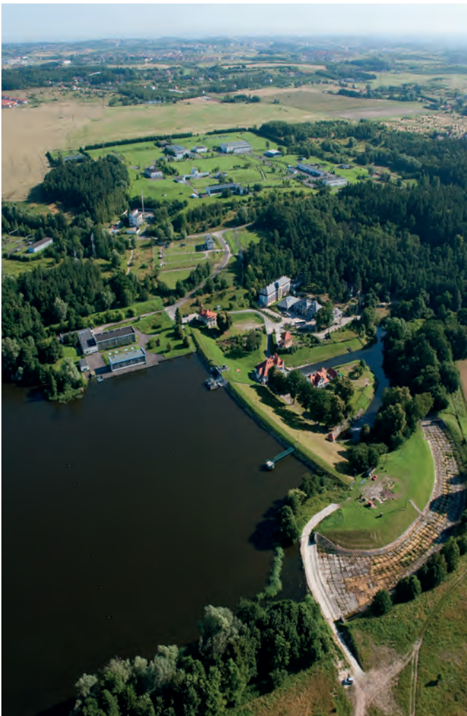
Ryc. 2. Zbiornik ujmowania wód powierzchniowych
