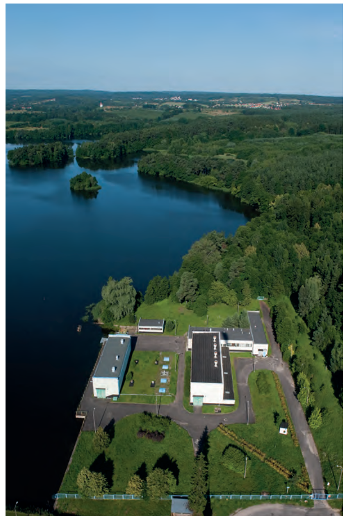
Ryc. 3. Stacja uzdatniania wody „Straszyn”. Wszystkie fot. z arch. Gdańskiej Infrastruktury Wodociągowo-Kanalizacyjnej Sp. z o.o.
