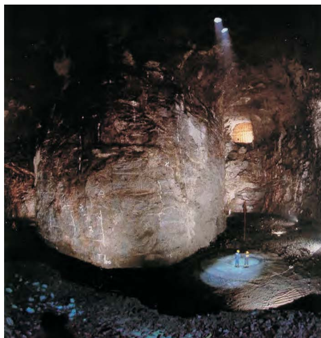
Ryc. 5. Prace budowlane przy kawernie w Lyckebo, Szwecja (Hellström, 2012)
