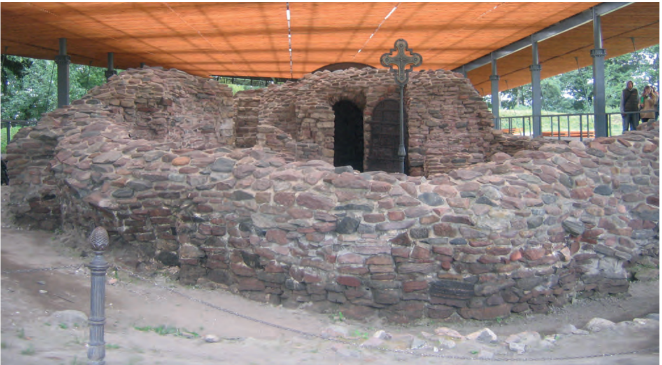
Ryc. 5. Ostrów Lednicki. Widok od wschodu absydy kaplicy pałacowej Mieszka I i Bolesława Chrobrego. Zbudowana z piaskowców kwarcytowych jotnickich i kwarcytów, gnejsów i granitoidów. Obie fot. J. Skoczylas Fig. 5. Ostrów Lednicki. View from the east on the chapel apse at Mieszko I and Bolesław Chrobry's palace. Built of the Jotnian quartzite sandstone, gneisses and granitoids. Both photos by J. Skoczylas
