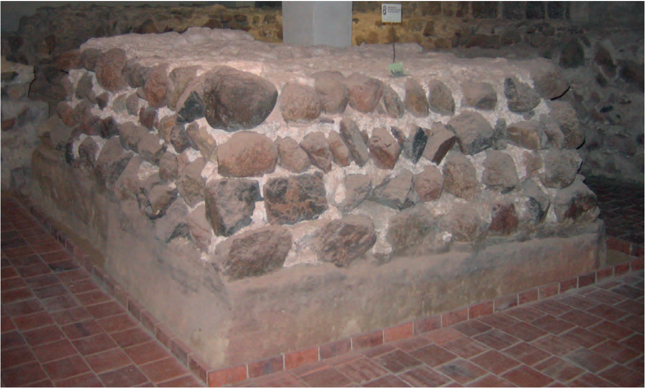
Ryc. 1. Gniezno. Podstawa ołtarza wykonana z głazów narzutowych w trójnawowej katedrze (XI w.), tzw. stypes Fig. 1. Gniezno. The so-called stypes , which is the base of the altar made of boulders in a three-aisled cathedral (11 th century)
