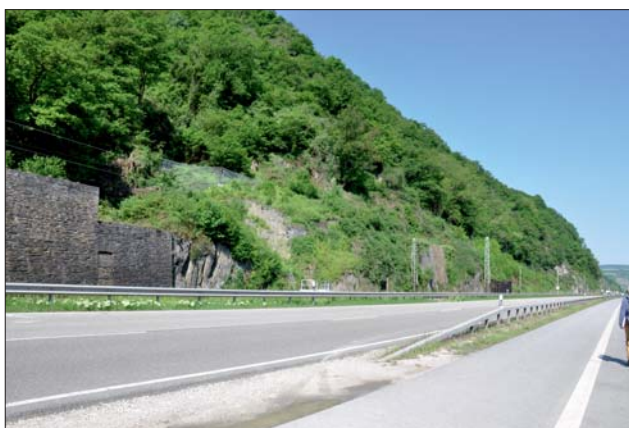
Ryc. 2. Stabilizacja przed obrywami i sływami gruzowymi lewego zbocza doliny Środkowego Renu w miejscowości Bacharach – w dolnej części mur oporowy, w środkowej ochronna siatka pierścieniowa wykonana po uaktywnieniu osuwiska w 2016 r.
