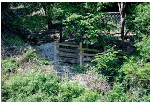
Ryc. 3. Szczegóły z ryc. 2 – zabezpieczenie potencjalnego sływu gruzowego w obrębie łupków dewońskich za pomocą barier ochronnych i siatek pierścieniowych firmy Geobrugg ze Szwajcarii
