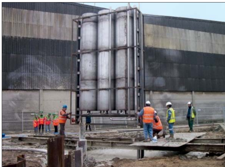
Ryc. 9. Przepuszczalna bariera reaktywna wypełniona żelazem zerowartościowym. Fot. Arch. Menard Fig. 9. The permeable reactive barrier filled with iron. Photo Menard Archive
