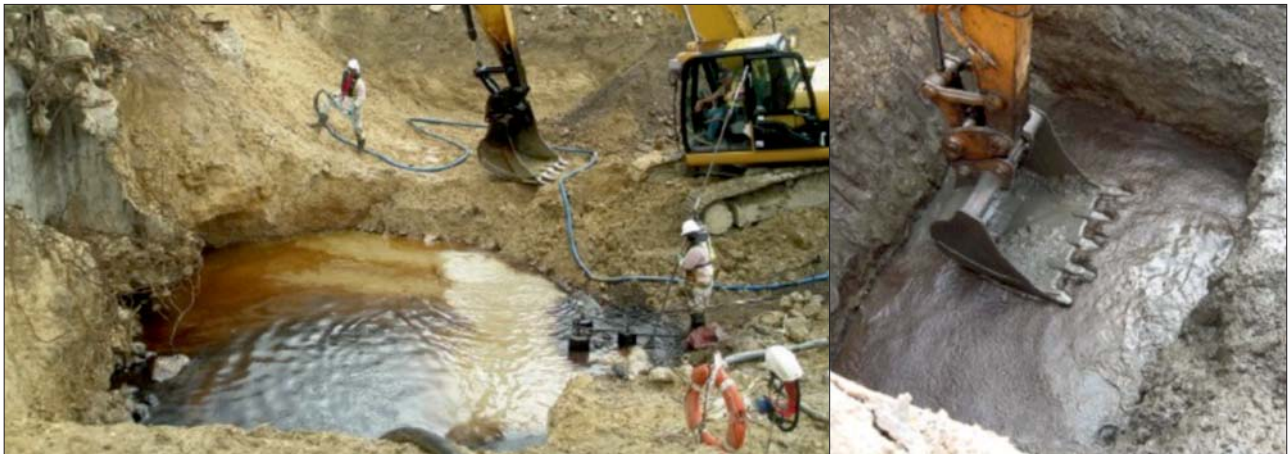
Ryc. 6. Szczypanie wolnego produktu z lustra wody. Fot. Arch. Menard
