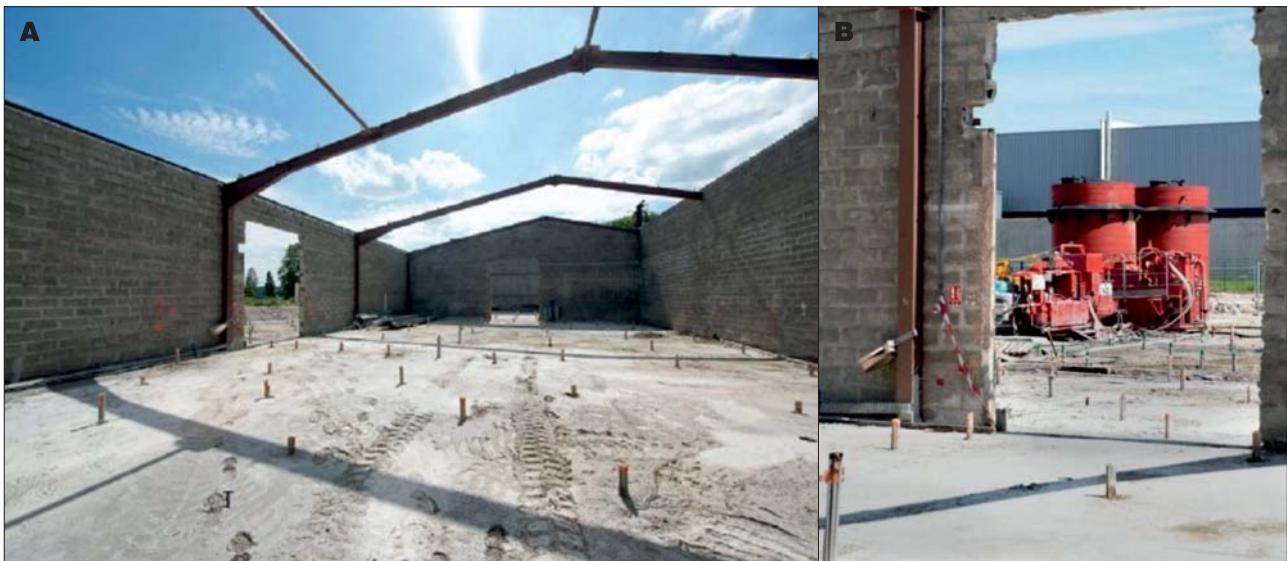
Ryc. 3. Metoda stabilizacji; A – siatka punktów iniekcyjnych; B – jednostka produkująca reagent. Fot. Arch. Menard Fig. 3. Stabilization method; A – grid of injection points; B – reagent production unit. Photo Menard Archieve
