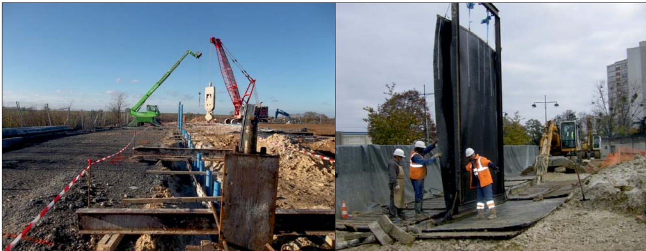
Ryc. 7. Bariery nieprzepuszczalne. Fot. Arch. Menard
